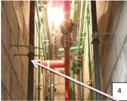
Auf Foto 4 ist exemplarisch dargestellt, dass für alle Schellen 2 Löcher gebohrt werden, was einen erheblichen Zeit- und Materialaufwand darstellt.
