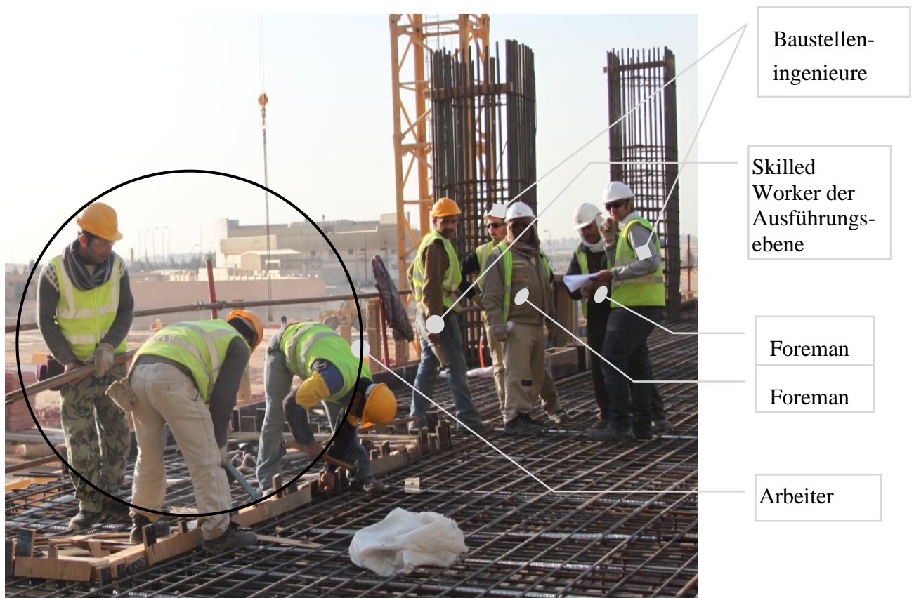
Abbildung 2: Baustellenarbeit in Ägypten
